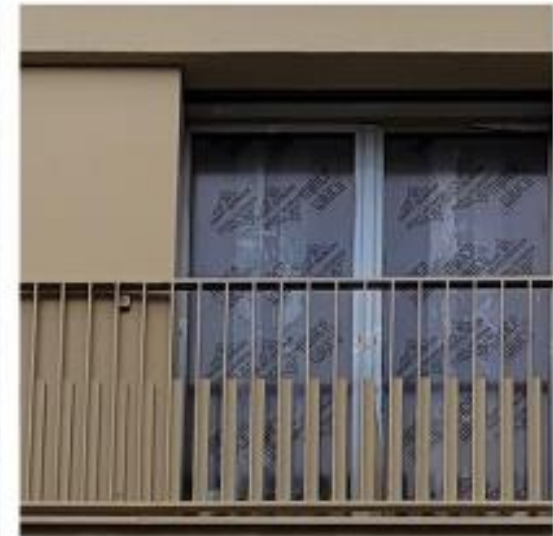
Garde-corps en serrurerie - Barreaudage vertical
