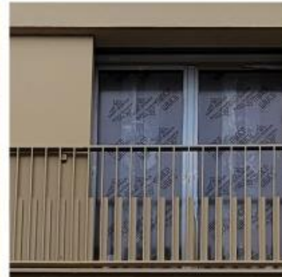
Garde-corps en serrurerie - Barreaudage vertical
